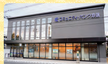
2025年3月に新築オープンした城陽支店
